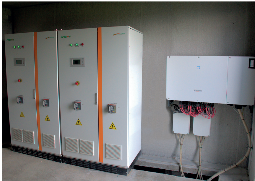
Sungrow SG100K3 e il nuovo SG110CX assieme in esercizio
