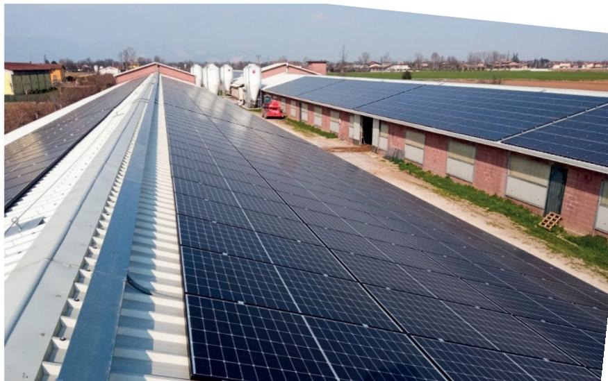
In concomitanza con il revamping dell'impianto, la copertura in Eternit è stata sostituita con lastre in lamiera grecata.
