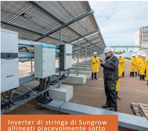
Inverter di stringa di Sungrow allineati piacevolmente sotto il sistema di montaggio
