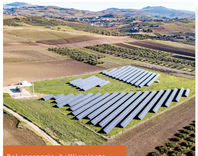
Bel paesaggio, bell'impianto
