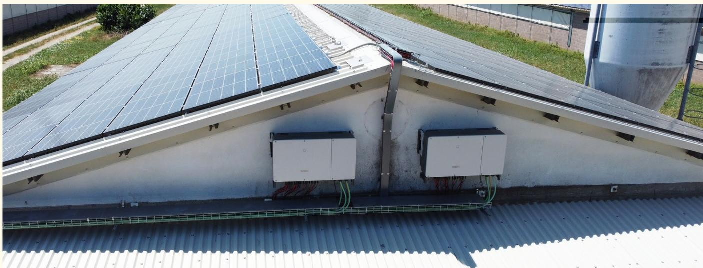
Gli inverter SG110CX sono stati installati sul lato nord, ombreggiato, e riparati dalla sporgenza della copertura, nonostante siano IP66 e resistenti alle intemperie.
