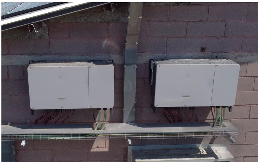
Grazie ai 9 MPPT e 18 ingressi per le stringhe, ciascun inverter SG110CX massimizza la produzione dell'energia fotovoltaica.
